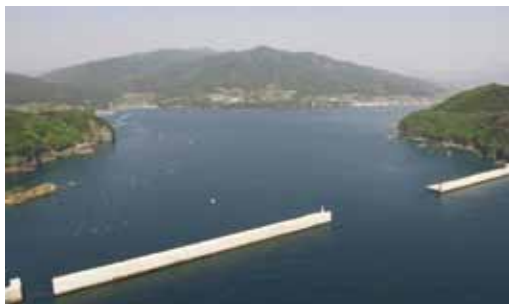
平成 29 年、湾口防波堤の復旧
