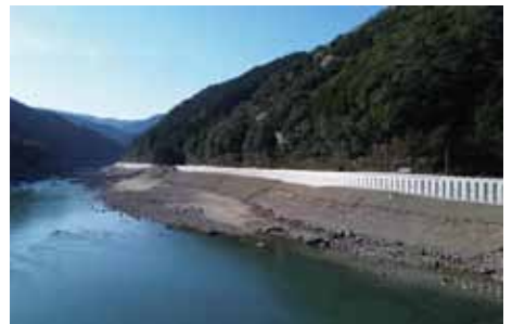
写真14 川嶽地区擁壁工（親杭パネル壁工法）
