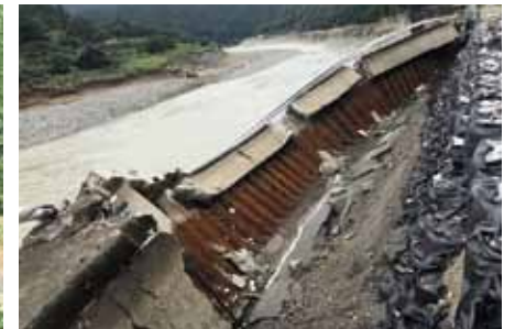
写真1（左）、2（右） 鋼管杭＋鋼矢板擁壁の倒壊（2020年7月撮影）
