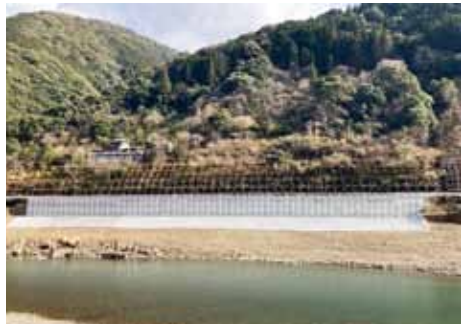
写真10 重力式擁壁の倒壊を『親杭パネル壁工法』で復旧（2022年3月撮影）
