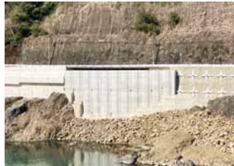
写真11 被災した現場打横矢板壁を『親杭パネル壁工法』で復旧（2023年3月撮影）
