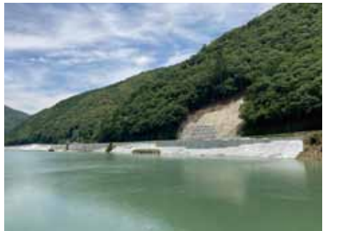
写真12 神瀬地区擁壁工（親杭パネル壁工法）
