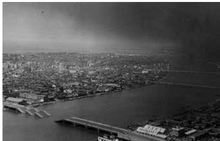
写真3 昭和大橋の被害(写真左側が左岸) 6)
