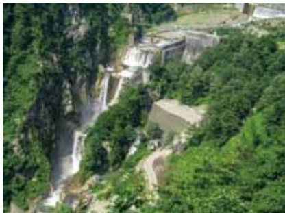
写真1 白岩砂防堰堤（提供 富山県）
