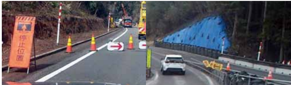
写真2 のと里山海道の状況
