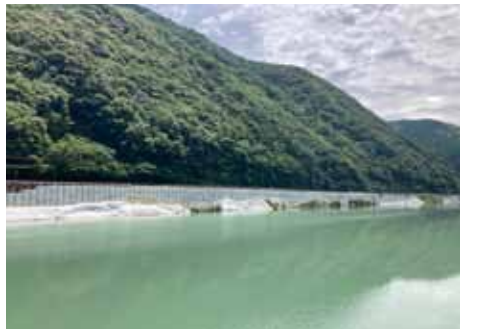
写真13 伊高瀬地区擁壁工（親杭パネル壁工法）
