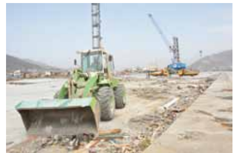
野々田埠頭のがれき撤去作業 （株）東海新報社提供
