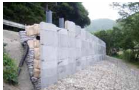
写真8 国道219号八代市坂本町坂本の親杭パネル壁（2014年竣工時/被災前撮影）
