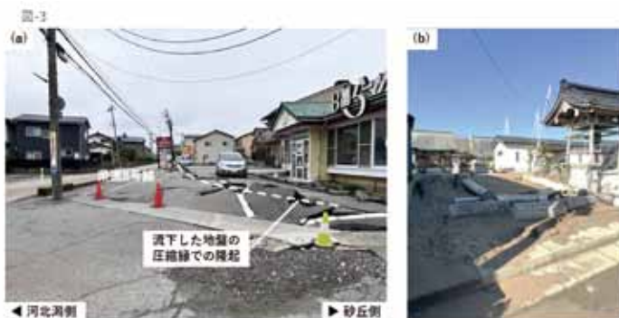
図 3 (a) 内灘町鶴ヶ丘で生じた県道 8 号線付近の隆起
