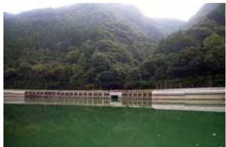
写真7 国道219号球磨村神瀬の現場打横矢板壁（2012年撮影）
