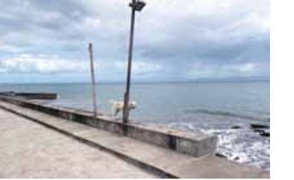
写真8 レイテ島の防潮堤
