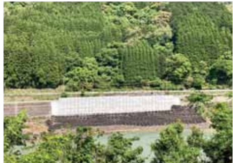
写真9 鋼管杭+鋼矢板擁壁の倒壊を『親杭パネル壁工法』で復旧（2023年5月撮影）
