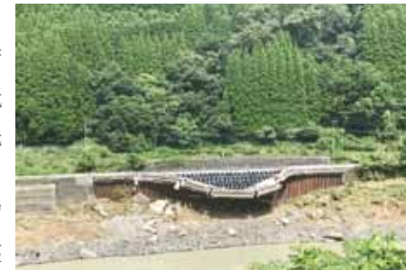
写真1（左）、2（右） 鋼管杭＋鋼矢板擁壁の倒壊（2020年7月撮影）
