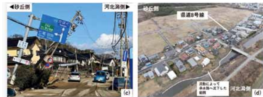
図 3 (c) 内灘町西荒屋での舗装の不陸と住宅や電柱類の傾斜
