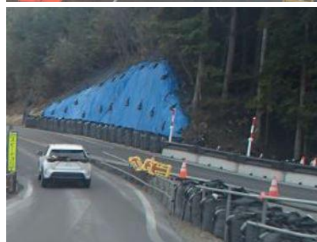
写真-2 のと里山海道復旧工事状況
