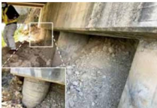
写真4 デミルコプルで円弧滑り破壊した橋台周辺地盤
