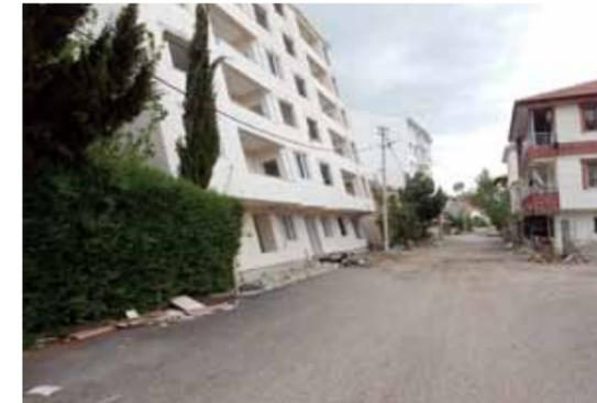
写真2 ギョルバシ市街地内での5階建てのアパートの傾斜
