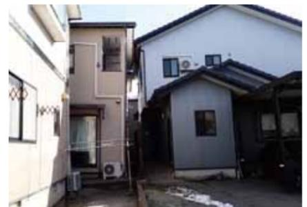
写真5 液状化による被害(傾斜)
