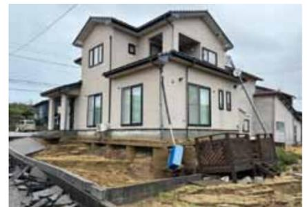
写真4 地盤改良を施した家屋と周辺の液状化被害
