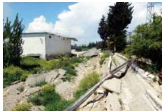
写真5 デミルコプルで側方流動した農業施設
