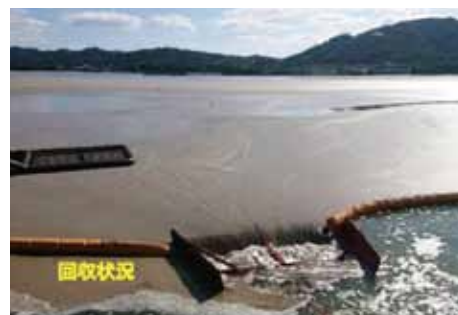
砂採取船による回収状況
