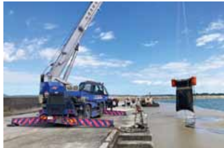
鋼製枠（小）による回収方法
