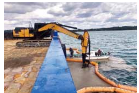
汚濁防止膜による回収概要図
