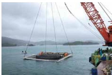
鋼製枠（大）による回収方法
