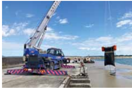
鋼製枠（小）による回収方法
