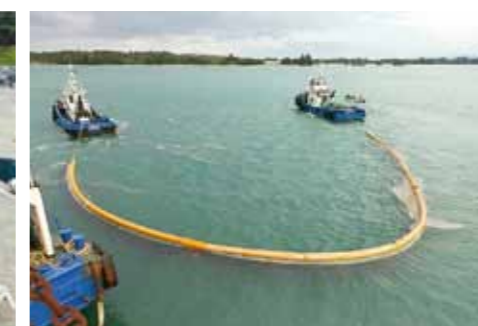
汚濁防止膜とバックホウによる回収方法
