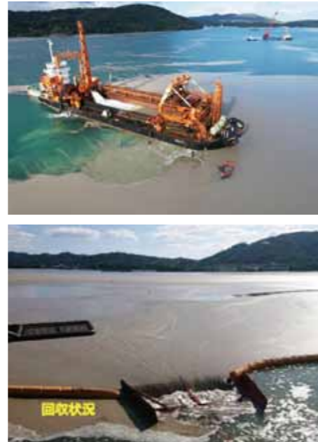
砂採取船による回収状況
