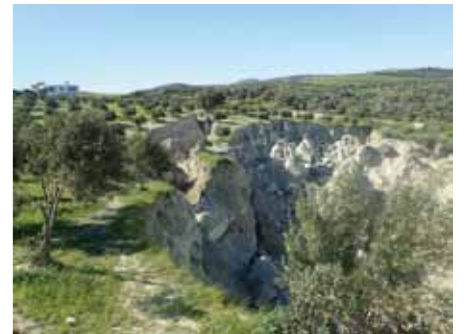
写真4 緩斜面地盤の被害
