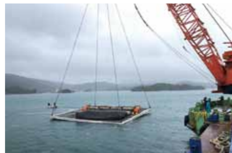
鋼製枠（大）による回収方法
