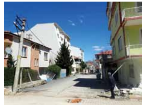
写真2 集合住宅の被害 (傾斜)
