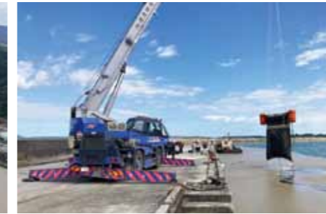
鋼製枠（小）による回収方法
