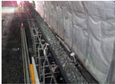
写真2 ベルトコンベヤ設備
