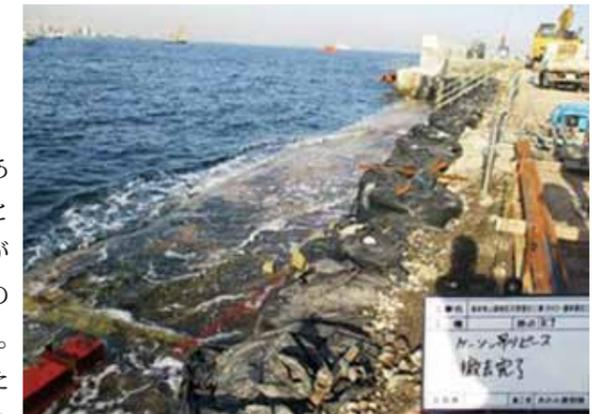
写真7 上部工撤去 大型土のう設置
