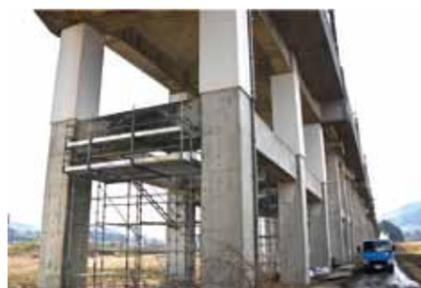
写真1 2021年2月13日の福島県沖の地震で被害を受けたRC二層式ラーメン構造の鉄道高架橋
