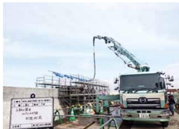
写真12 上部工コンクリート打設
