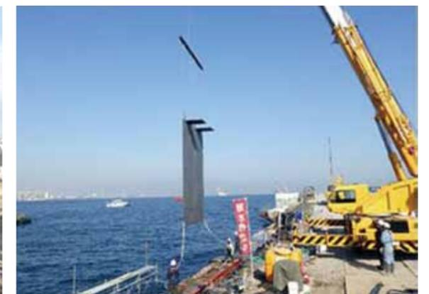
写真9 ケーソン復旧 鋼板設置
