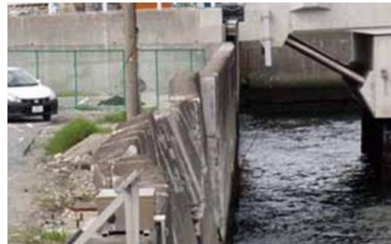
写真6 上部工破損状況 (護岸際から撮影)
