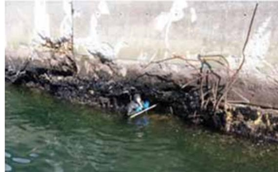
写真3 ケーソン天端付近の破損状況
