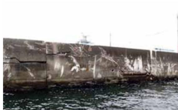
写真5 上部工破損状況 (海側から撮影)
