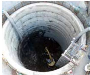
写真3 橋脚基礎（深礎工法）
