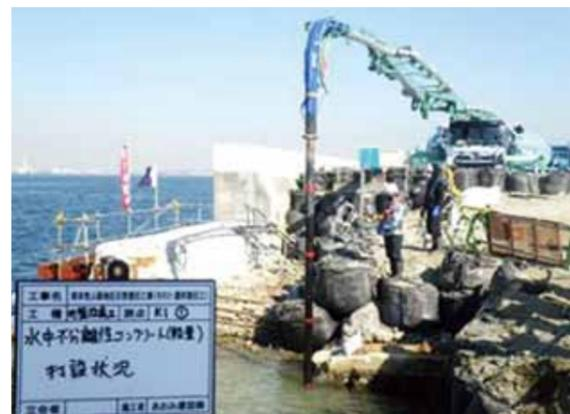
写真11 水中不分離性コンクリート打設
