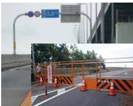
写真7 通行止めになった鳴尾橋
