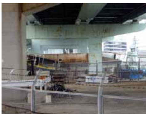
写真6 鳴尾橋に衝突したバージ
