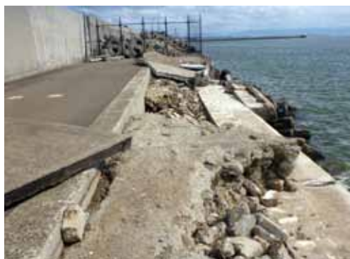
写真3 護岸の被災状況
