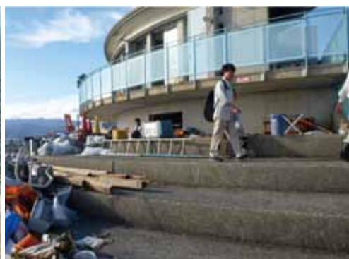
写真4 波流入による管理事務所のガラス被災
