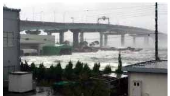
写真1 台風21号による高潮の状況
