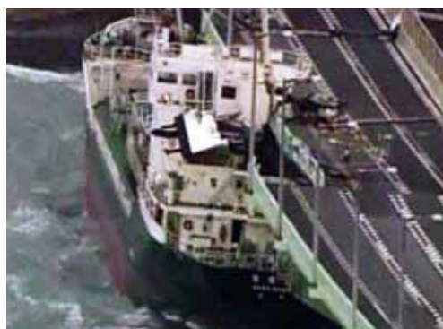
写真5 関空連絡橋に衝突したタンカー（近畿地方整備局）
