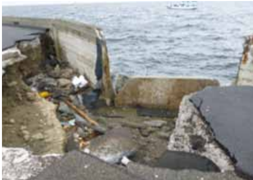
写真-1 L型擁壁倒壊・陥没状況
