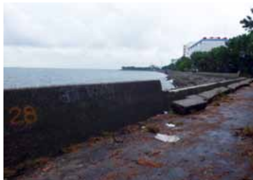
写真-4 護岸上部工倒壊状況
