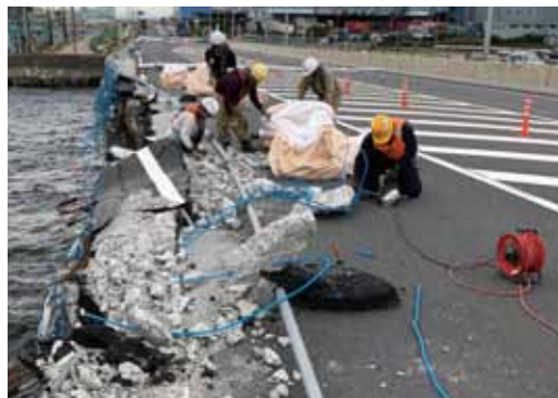
写真-17 がれき撤去状況
