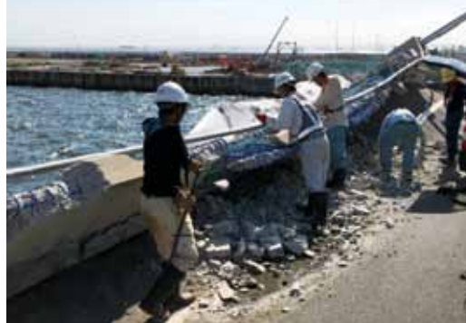
写真-18 がれき撤去状況
