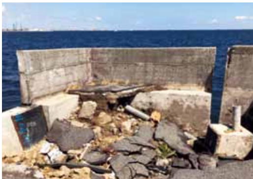
写真-3 長浜水路南側被災状況
