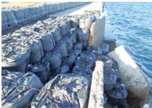
写真-9 L型擁壁倒壊箇所復旧完了
