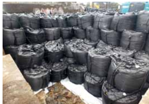
写真-10 陥没箇所復旧完了
