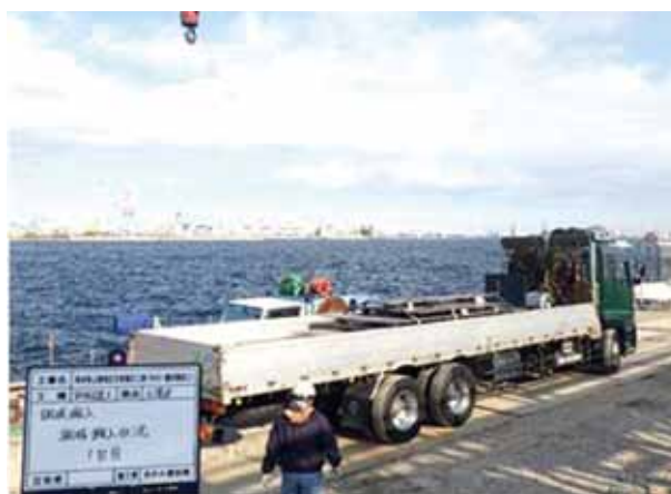
写真8 ケーソン復旧 鋼板搬入
