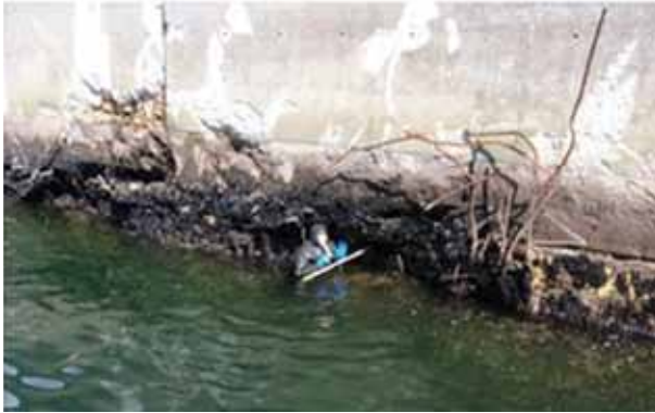
写真3 ケーソン天端付近の破損状況
