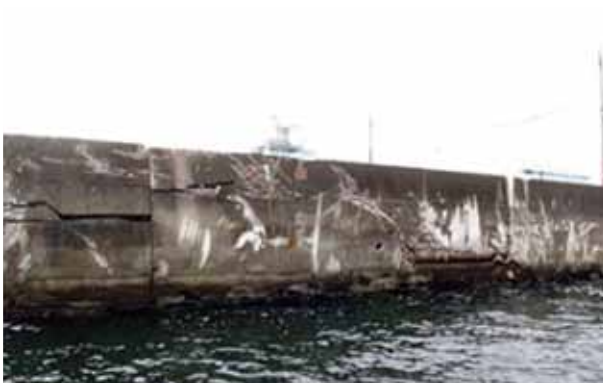
写真5 上部工破損状況 (海側から撮影)
