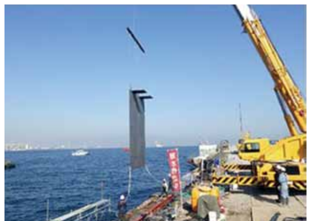
写真9 ケーソン復旧 鋼板設置
