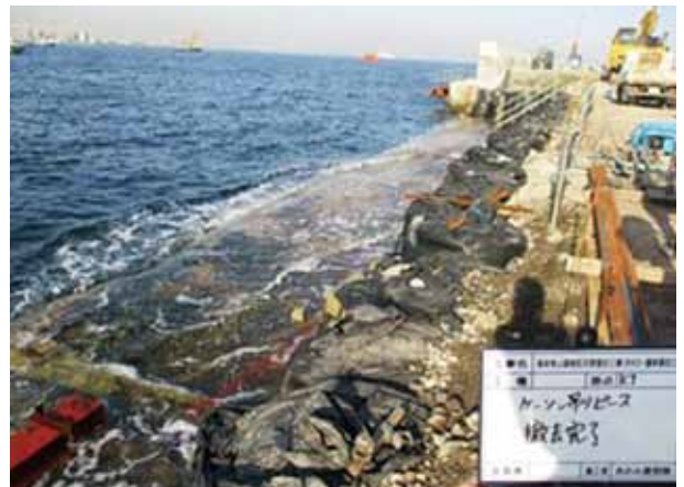
写真7 上部工撤去 大型土のう設置
