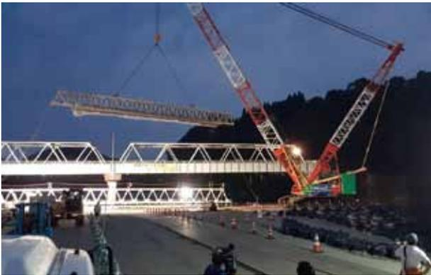
写真11 仮桁の架設
