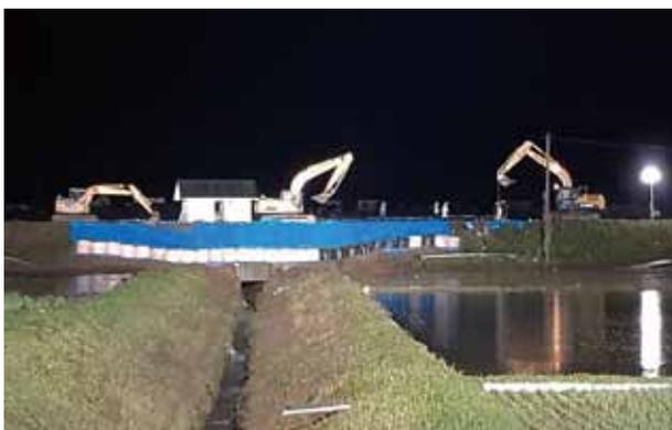
写真7 堤防の応急復旧工事
