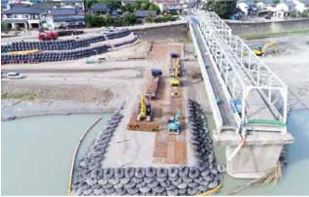
写真9 仮設ヤードの築造
