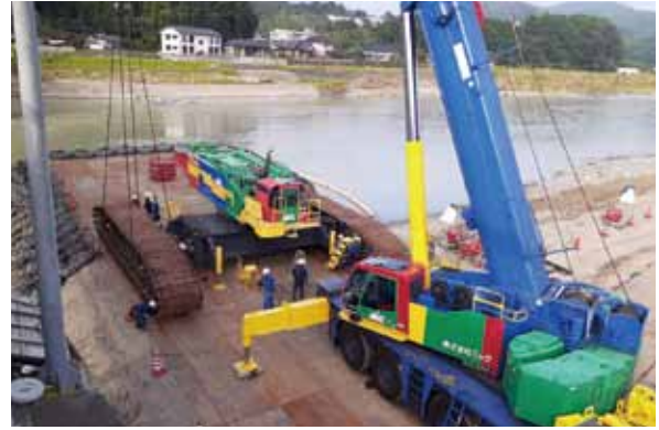
写真10 500t クレーンの組立
