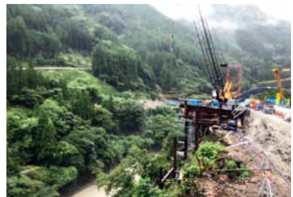
写真2 施工状況（川辺川は増水）
