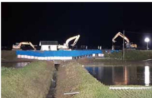
写真7 堤防の応急復旧工事
