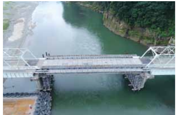
写真12 西瀬橋の仮開通
