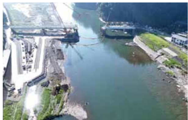
写真8 西瀬橋の復旧工事
