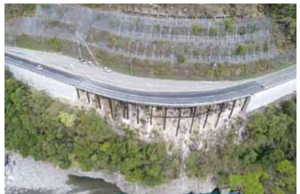
写真13 写真2現場の完成写真(2021年3月)
