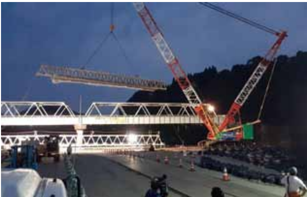
写真11 仮桁の架設
