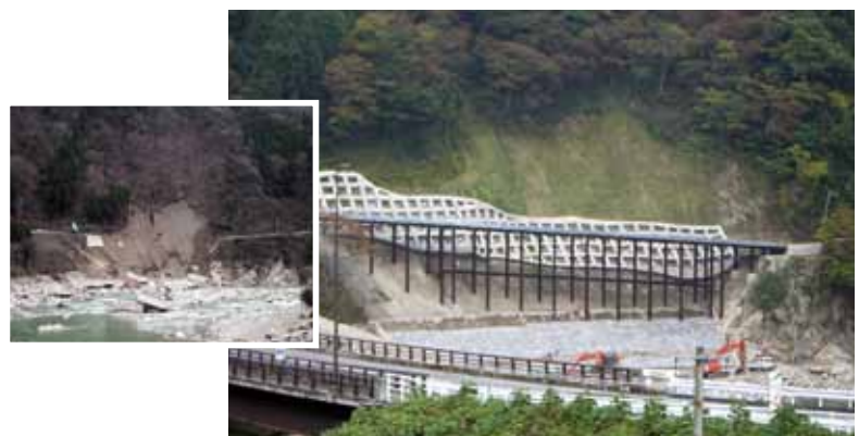
写真1 岐阜県 災害復旧工事の例（災害直後、復旧完了）
