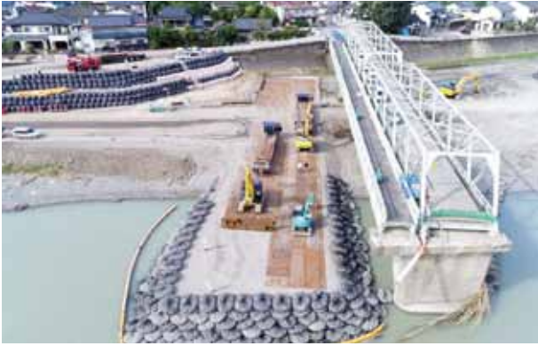
写真9 仮設ヤードの築造
