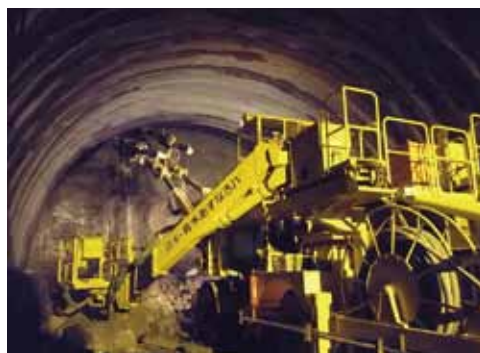
写真1 トンネル施工状況
