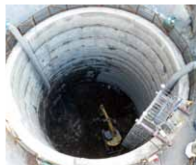
写真3 橋脚基礎(深礎工法)
