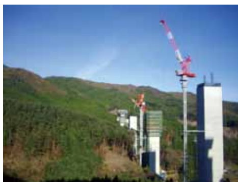
写真6 橋脚施工状況 (ACS)
