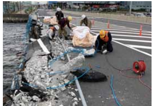
写真-17 がれき撤去状況
