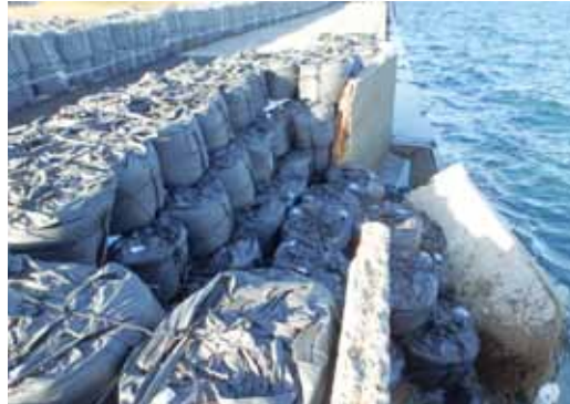
写真-9 L型擁壁倒壊箇所復旧完了
