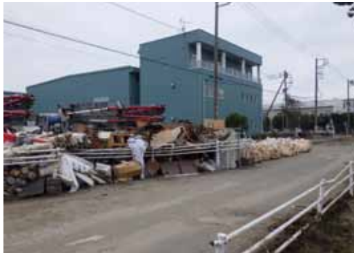
写真-5 周辺の被災状況
