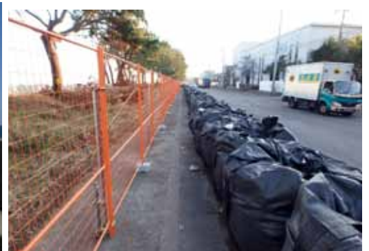
写真-12 大型土のう設置完了（護岸背面道路）
