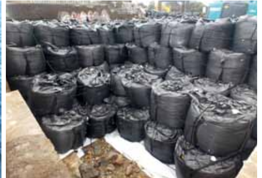
写真-10 陥没箇所復旧完了
