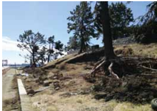
写真-2 高波越波状況
