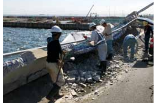
写真-18 がれき撤去状況
