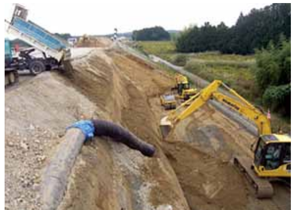
写真 2 盛土部の復旧作業状況
