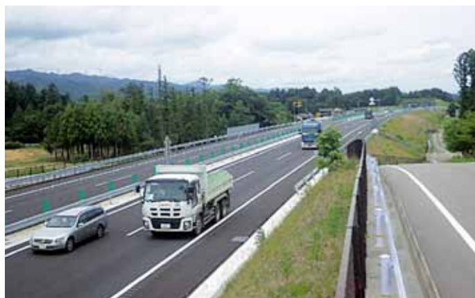
写真 4 全線開通した常磐自動車道／南相馬市・浪江町付近
