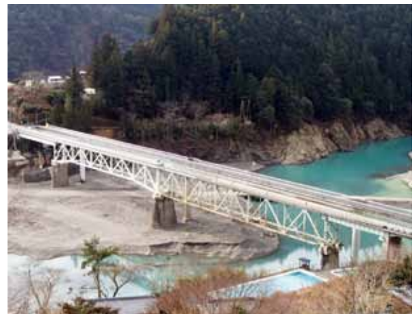
写真-8 本復旧の工事実施状況
