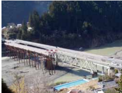
写真-7 豪雨による増水で流失した橋
