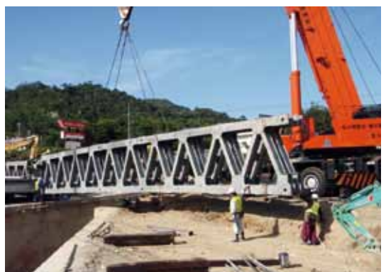
写真-6 応急組立橋の架設
