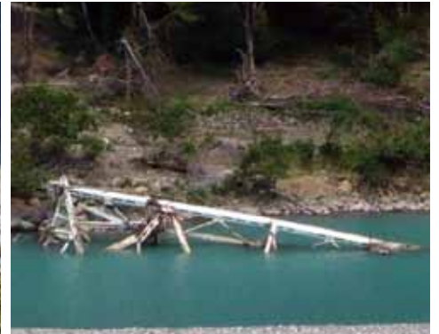
写真-7 豪雨による増水で流失した橋
