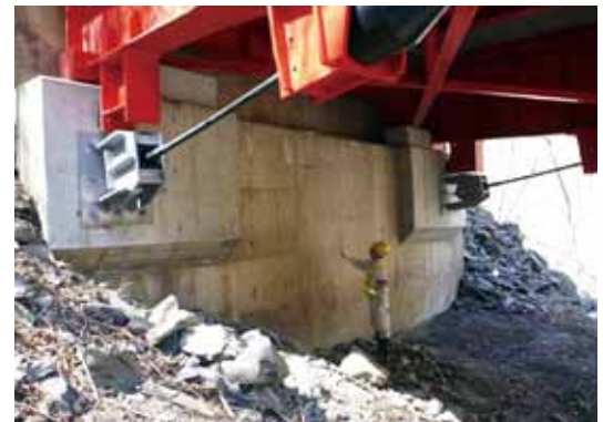
写真-2 災害発生時の緊急点検状況
