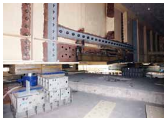
写真-10 支点仮受けと補強改造
