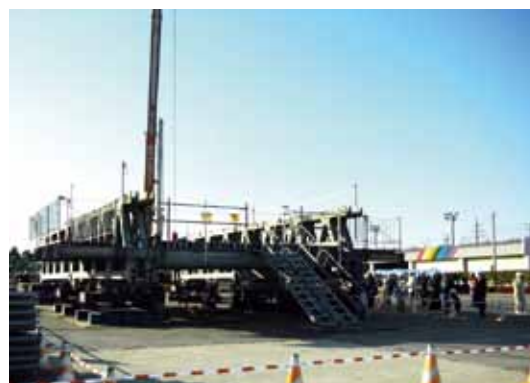
写真-5 応急組立橋の研修会
