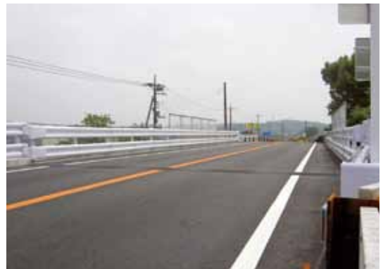
写真-4 完成した応急橋の路面の様子
