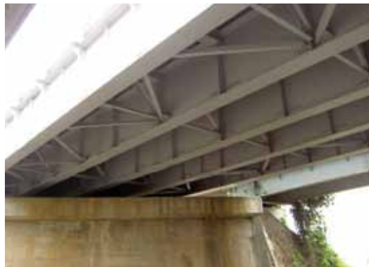
写真-3 応急橋の設置例
