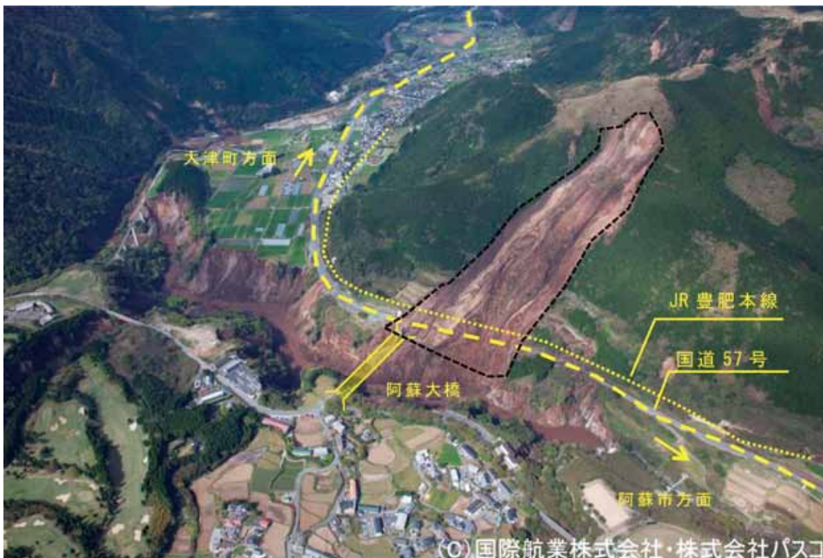
写真-1 阿蘇大橋地区の被災状況(国際航業株式会社・株式会社パスコ共同撮影)
