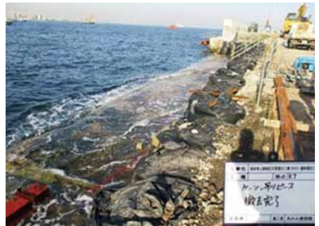
写真7 上部工撤去 大型土のう設置
