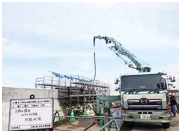
写真12 上部工コンクリート打設
