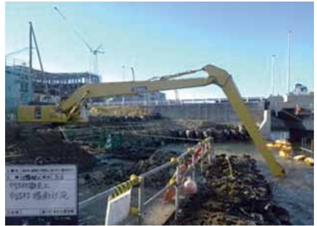
写真10 超ロングリーチバックホウによる中詰材撤去
