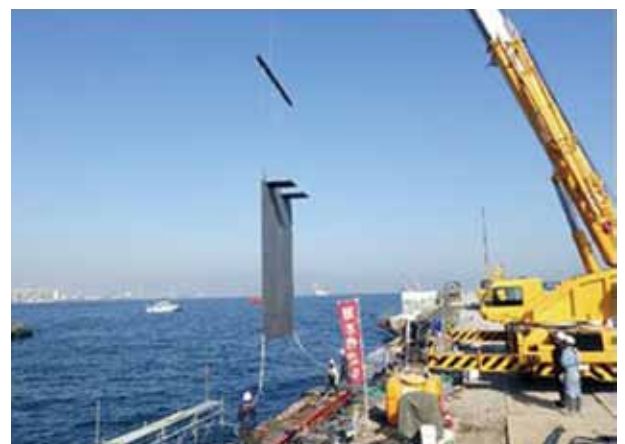
写真9 ケーソン復旧 鋼板設置
