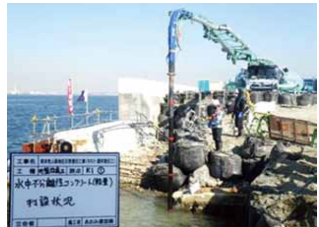
写真11 水中不分離性コンクリート打設
