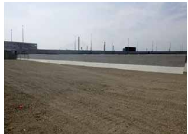
写真13 護岸復旧工事完成
