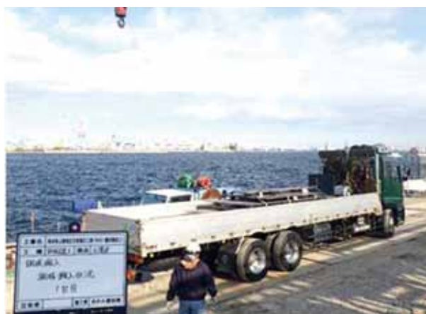
写真8 ケーソン復旧 鋼板搬入
