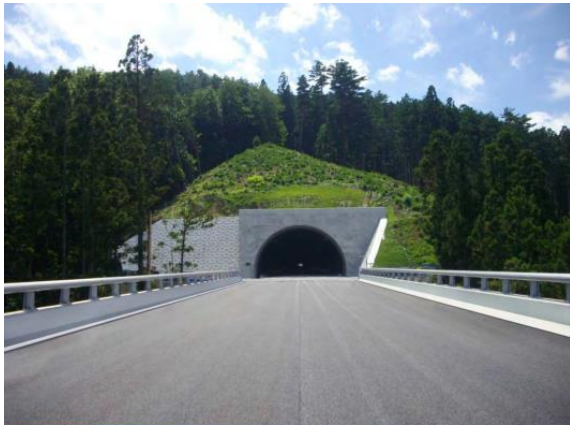
吉浜トンネル L=1644m
