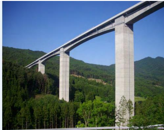
越喜来高架橋 (L=584m) 下部工 3本 H≒70m
