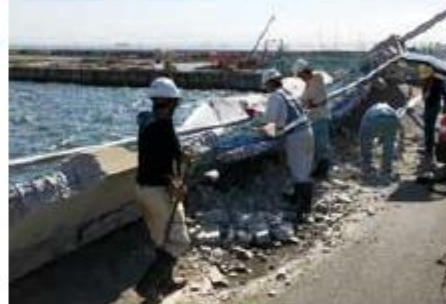
写真-18 がれき撤去状況
