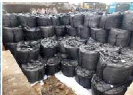
写真-10 陥没箇所復旧完了
