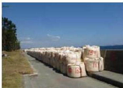
写真-11 大型土のう設置完了（水際線護岸）
