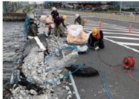
写真-17 がれき撤去状況
