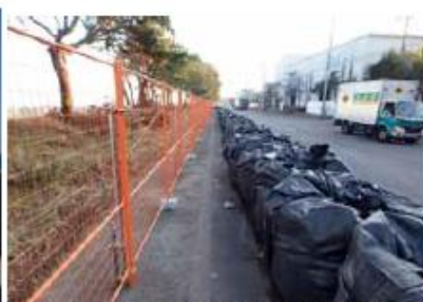
写真-12 大型土のう設置完了（護岸背面道路）
