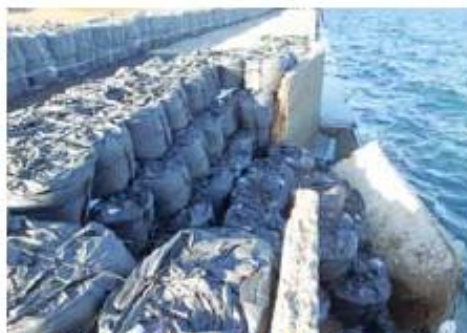
写真-9 L型擁壁倒壊箇所復旧完了
