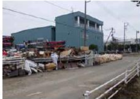
写真-5 周辺の被災状況
