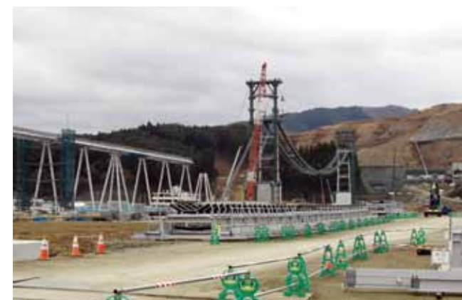
陸前高田市の再生は山を削り、コンベアで土運搬して地盤を嵩上げした。
