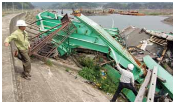
陸前高田・気仙川の上流に流された橋桁の残骸。
