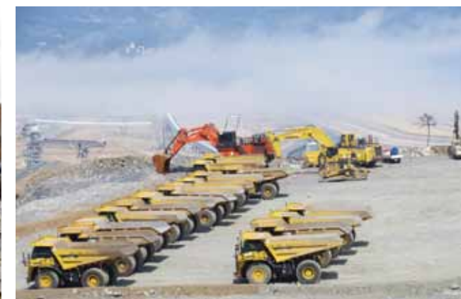
陸前高田市の再生は山を削り、コンベアで土運搬して地盤を嵩上げした。
