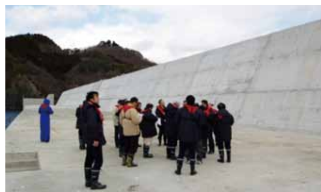
新設された防潮堤
