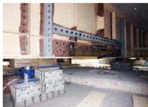
写真-10 支点仮受けと補強改造
