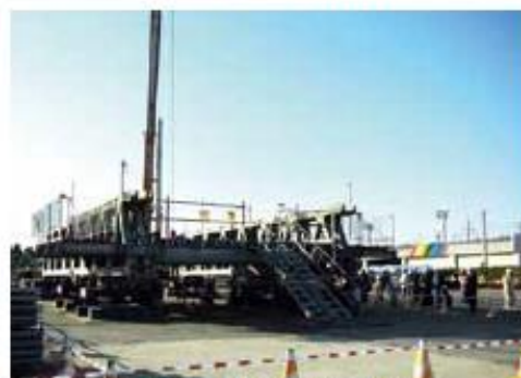
写真-5 応急組立橋の研修会
