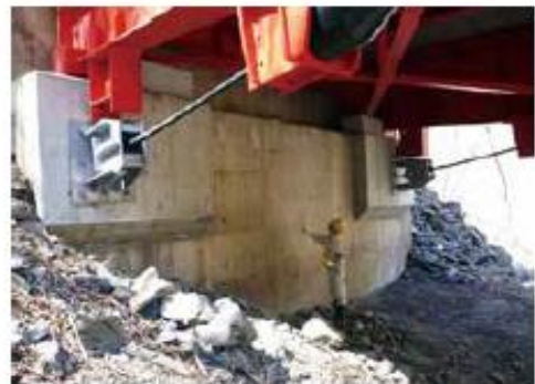
写真-2 災害発生時の緊急点検状況
