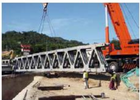
写真-6 応急組立橋の架設
