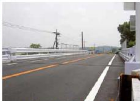
写真-4 完成した応急橋の路面の様子
