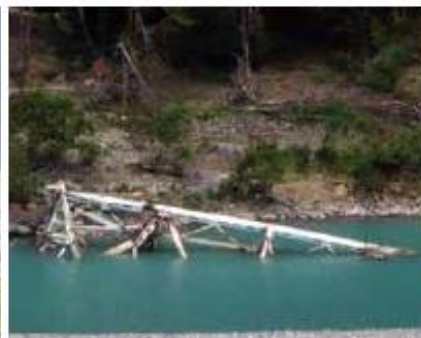
写真-7 豪雨による増水で流失した橋
