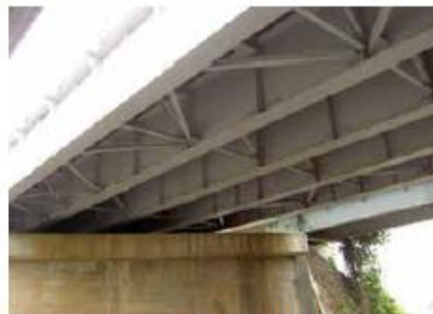
写真-3 応急橋の設置例
