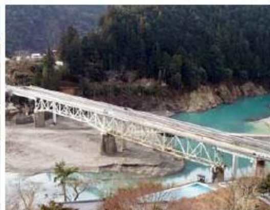
写真-8 本復旧の工事実施状況
