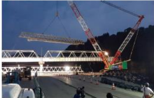
写真11 仮桁の架設
