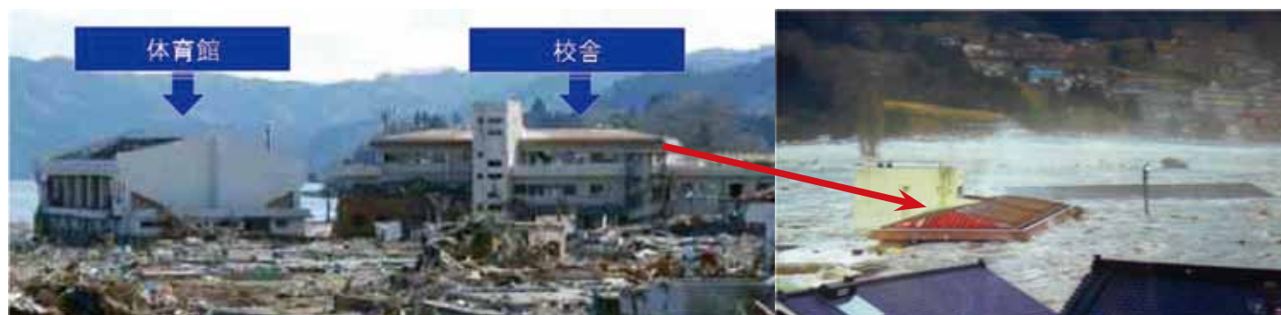
写真1 津波で全壊した越喜来小学校。
