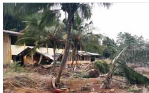
写真8 校庭の土石流木材被害
