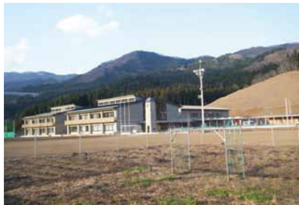
校舎は高台に移転された（28 年 11 月）。
