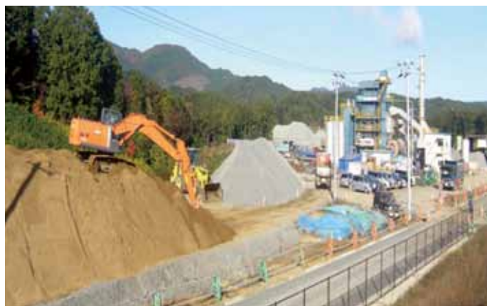
写真 3 碎石・砂のストック状況
