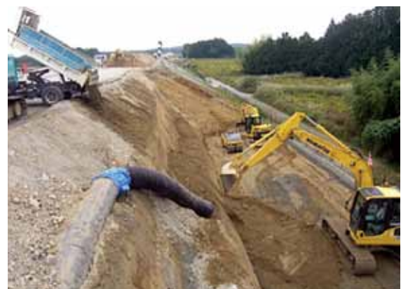
写真 2 盛土部の復旧作業状況
