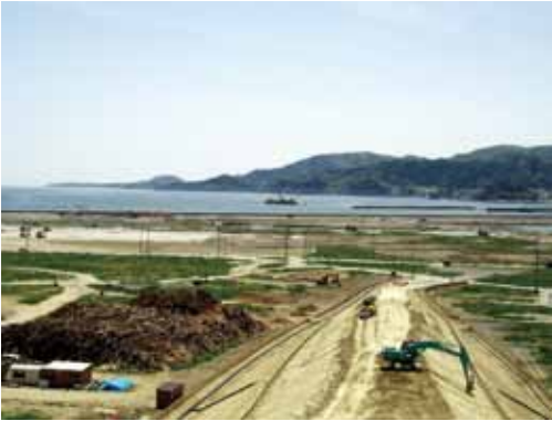
写真 4 津波で壊滅した陸前高田市の市街地は現在、嵩上げ土地造成が進行中。
