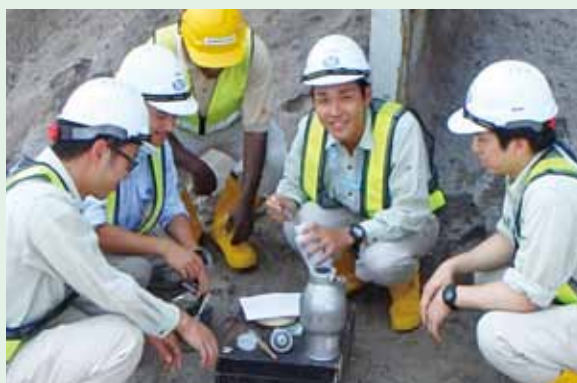
マレーシア、セランゴール州（導水トンネルプロジェクト） パッチャープラントにて細骨材の表面含水率を測定しています。
