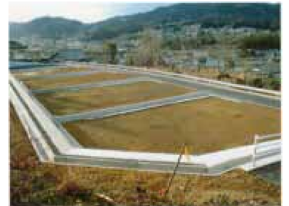
【写真－4】 小細浦集団移転団地の完成（山側から）
