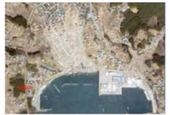
【写真 2】3.11 大震災津波の被災直後（↑）
