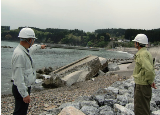
写真-3 転倒した防波堤現場調査
