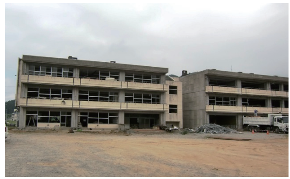
写真-7 解体工事が始まる赤崎小学校
