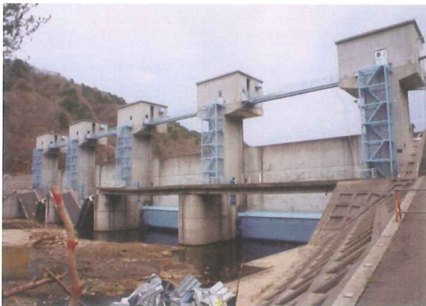
写真-1 普代水門
