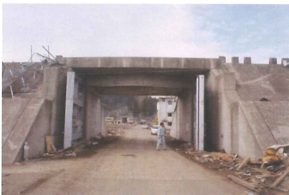
写真-3 防潮堤のゲート
