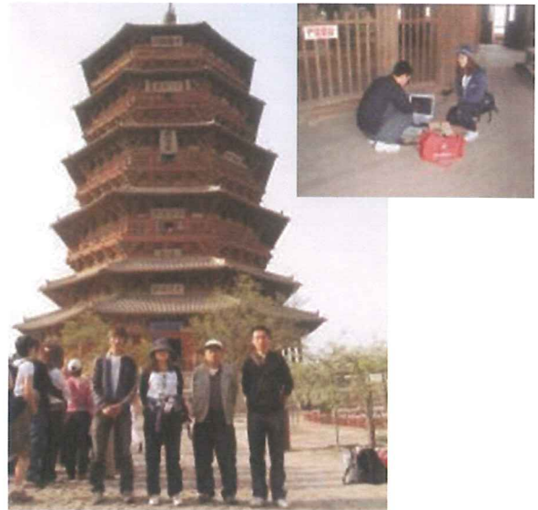
図7 応県木塔の常時微動観測
