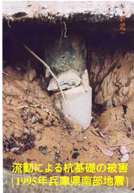
流動による杭基礎の被害
