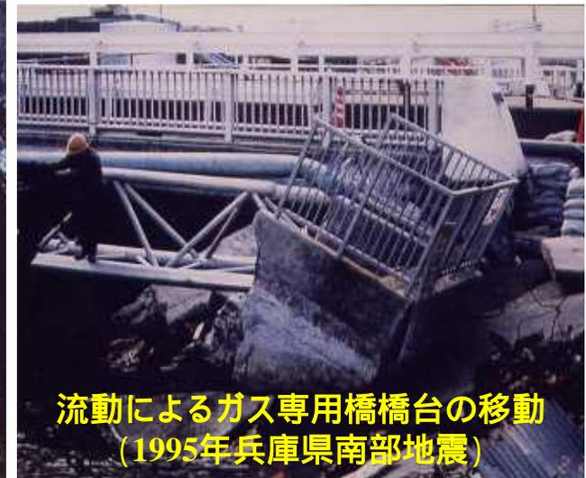
流動によるガス専用橋橋台の移動
