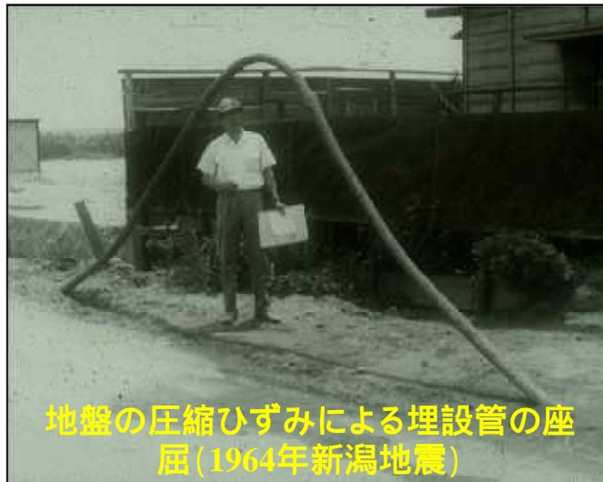
地盤の圧縮ひずみによる埋設管の座屈
