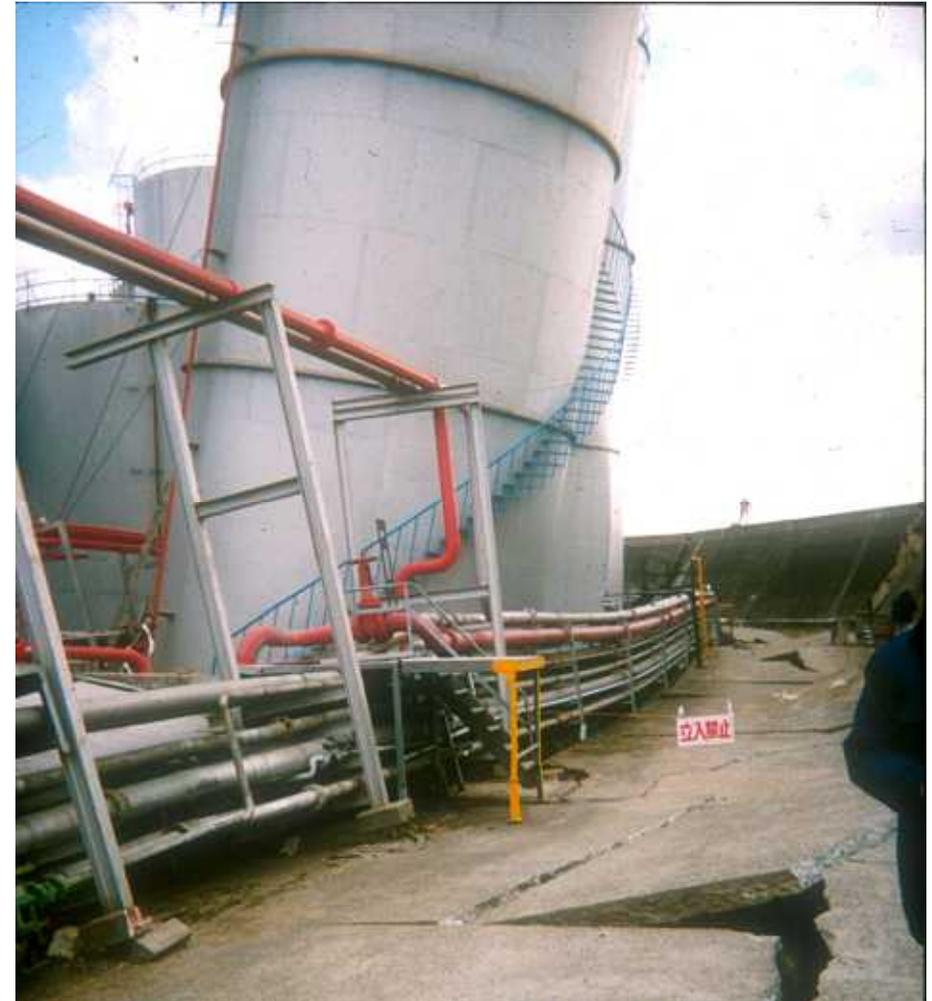
液状化によるタンクの傾斜・沈下・移動
