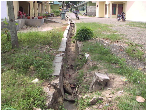
写真-15, 写真-16 軍宿舎の周辺地盤, 2005 年 3 月の地震で被害を受けた水路 (地盤が海側や河心方向に移動し, 水路に亀裂や傾斜がした)
