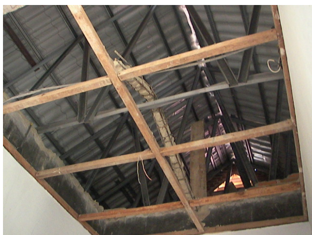
写真-11, 写真-12 前日の地震で被害の出た軍宿舎 (左は被害が出た並び(コントラクターが施工, 屋根や柱に化粧があるが施工は不良, 右は被害の無かった並び(軍の直接施工, 屋根や柱はシンプルであるがしっかり施工))
