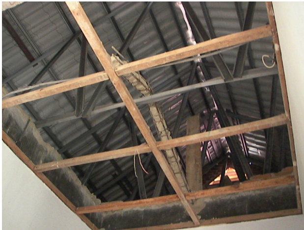
写真-40, 写真-41 グヌンシトリの軍宿舎：悪品質の材料の使用と施工不良
