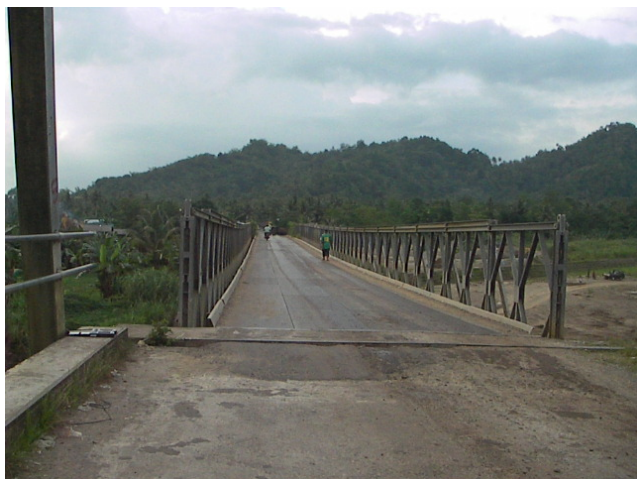
写真-36 架け替え予定の橋梁
