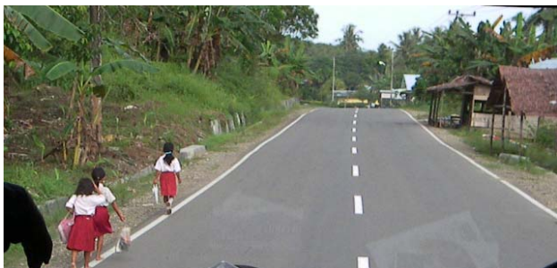
写真-34 道路の拡幅としっかりした舗装
