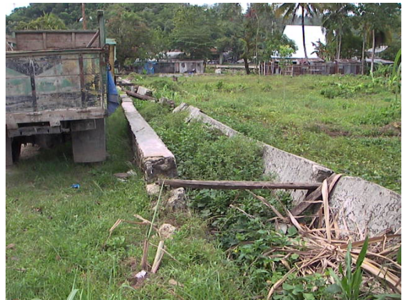
写真-15, 写真-16 軍宿舎の周辺地盤, 2005 年 3 月の地震で被害を受けた水路 (地盤が海側や河心方向に移動し, 水路に亀裂や傾斜がした)
