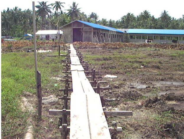
写真-44, 写真-45 南ニアステルケダラムの低湿地に建設された基礎構造が不十分なうえ壁が不安定な学校校舎
