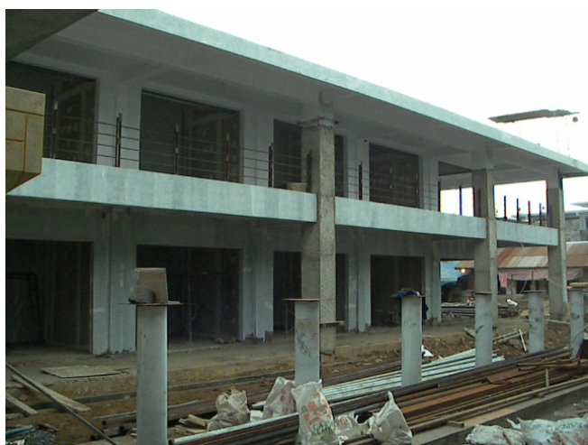
写真-38, 写真-39 埋立地に建設中の市場 柱、梁は従来のものより太く設計されている。 (ただし、基礎が検討不十分の可能性)
