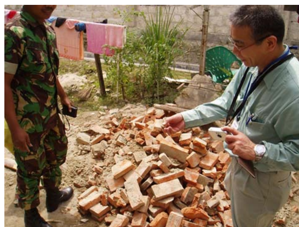
写真-11, 写真-12 前日の地震で被害の出た軍宿舎 (左は被害が出た並び(コントラクターが施工, 屋根や柱に化粧があるが施工は不良, 右は被害の無かった並び(軍の直接施工, 屋根や柱はシンプルであるがしっかり施工))
