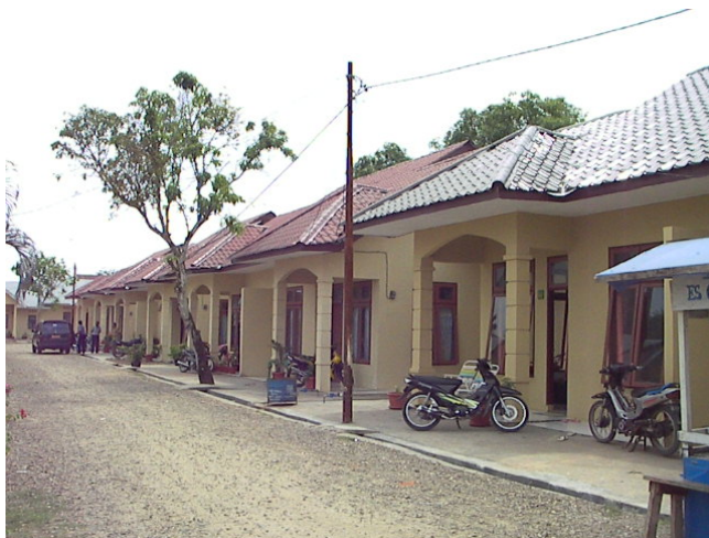
写真-11, 写真-12 前日の地震で被害の出た軍宿舎 (左は被害が出た並び(コントラクターが施工, 屋根や柱に化粧があるが施工は不良, 右は被害の無かった並び(軍の直接施工, 屋根や柱はシンプルであるがしっかり施工))
