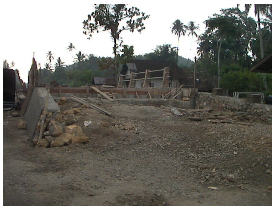
写真-35 道路の拡幅にあわせた橋の架け替え
