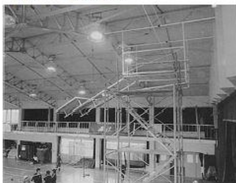
写真3 高所作業用足場
