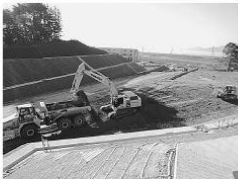
写真 2 造成工事状況 (2014年9月)
