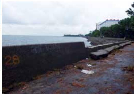
写真-4 護岸上部工倒壊状況
