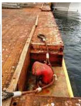
写真 4 岸壁の沈下は1mを超える。覆工板で高上げ。(気仙沼)
