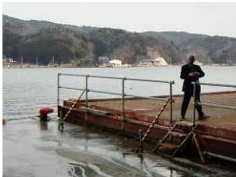
写真 4 岸壁の沈下は1mを超える。覆工板で高上げ。(氣仙沼)
