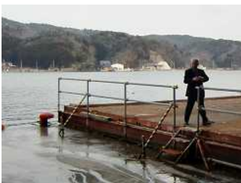
写真 4 岸壁の沈下は1mを超える。覆工板で高上げ。(気仙沼)
