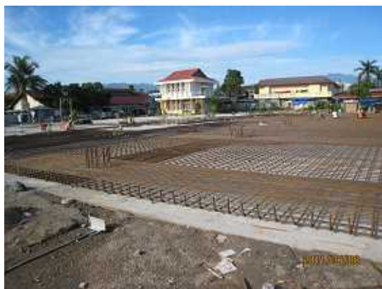
写真5 No.2 建物現場写真 2011.6.6 マットスラブ(厚300mm)配筋状況
