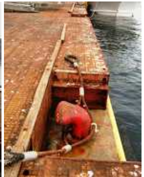
写真 4 岸壁の沈下は1mを超える。覆工板で高上げ。(氣仙沼)
