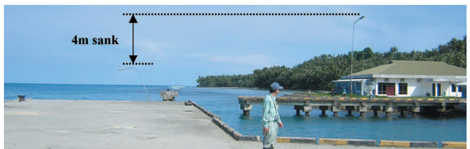
写真-3 テルクダラム港の栈橋の沈下、水没
